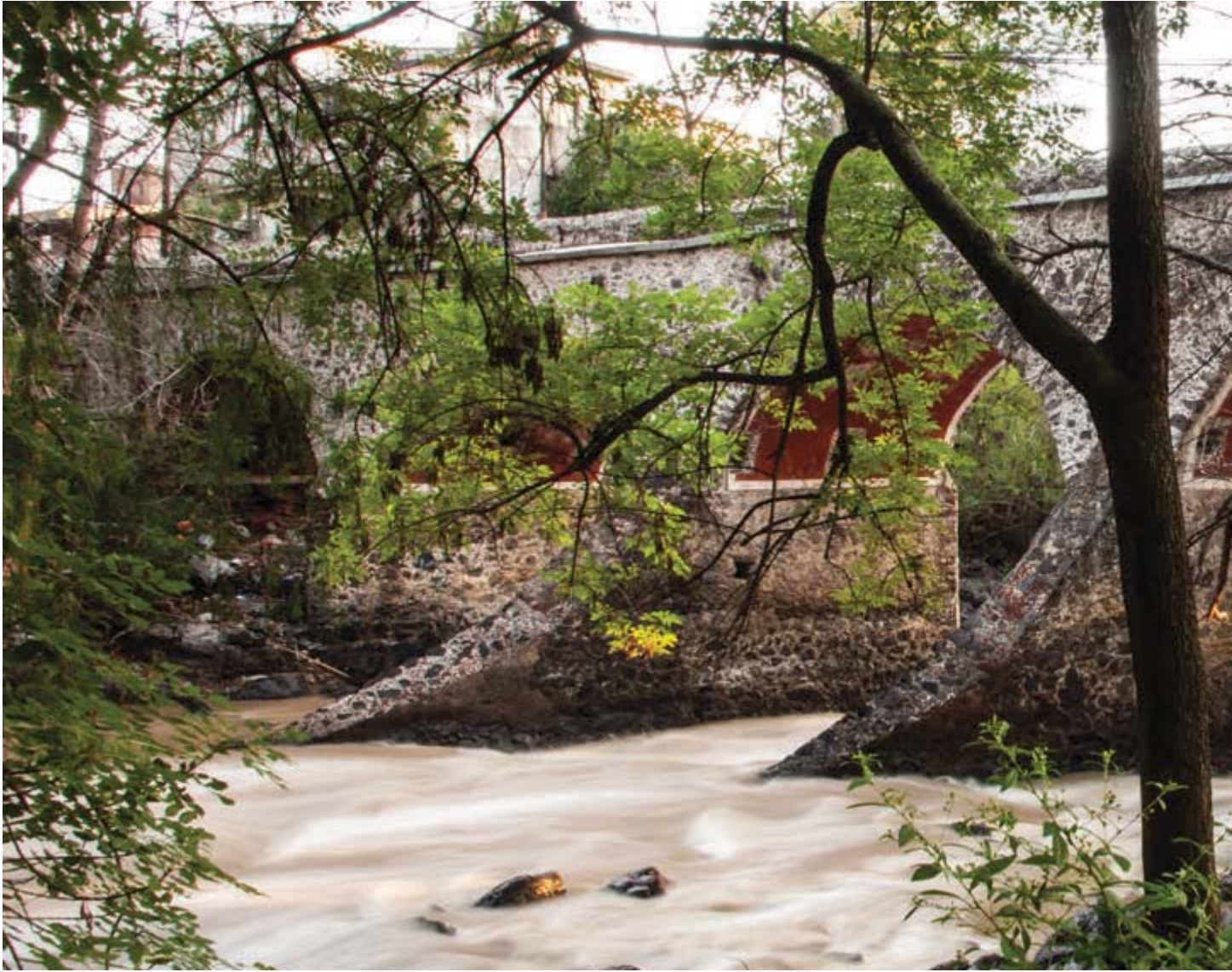
Puente Batanes, Guanajuato.
