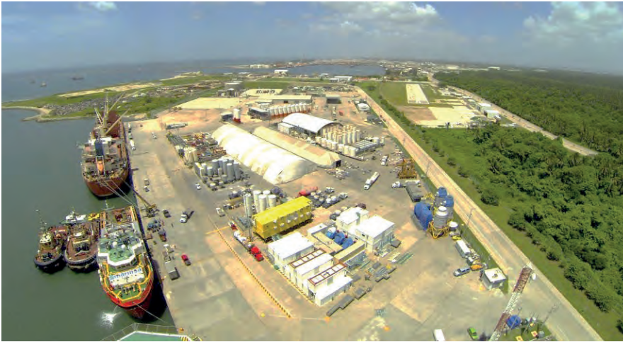
Imagen 1. Refinería Dos Bocas
