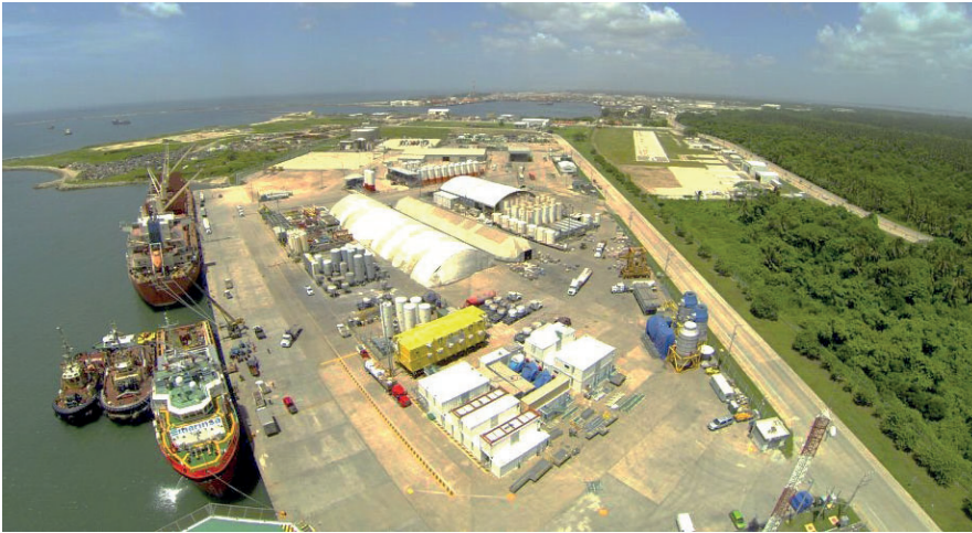
Imagen 1. Refinería Dos Bocas
